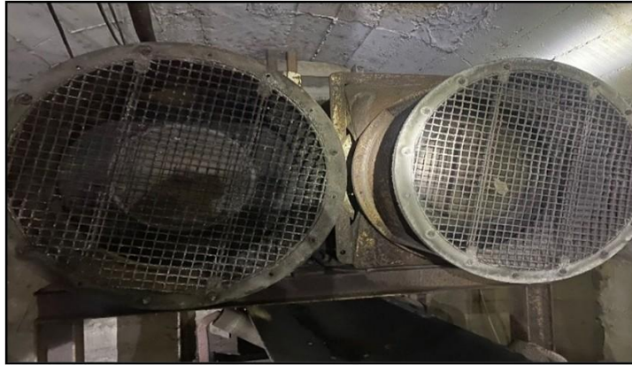
Gambar 4.4 Kipas Utama ( Main Fan ) Sistem Ventilasi
