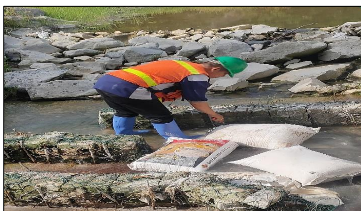
Gambar 4.7 proses pengapuran.
