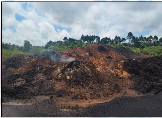
Gambar A.4 Titik Hotspot pada Area stockpile
