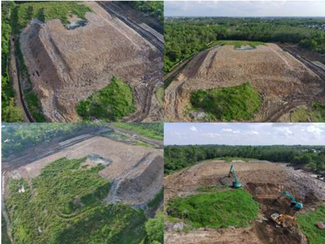
Gambar 1 Kondisi TPA Sungai Medang Kota Prabumulih
