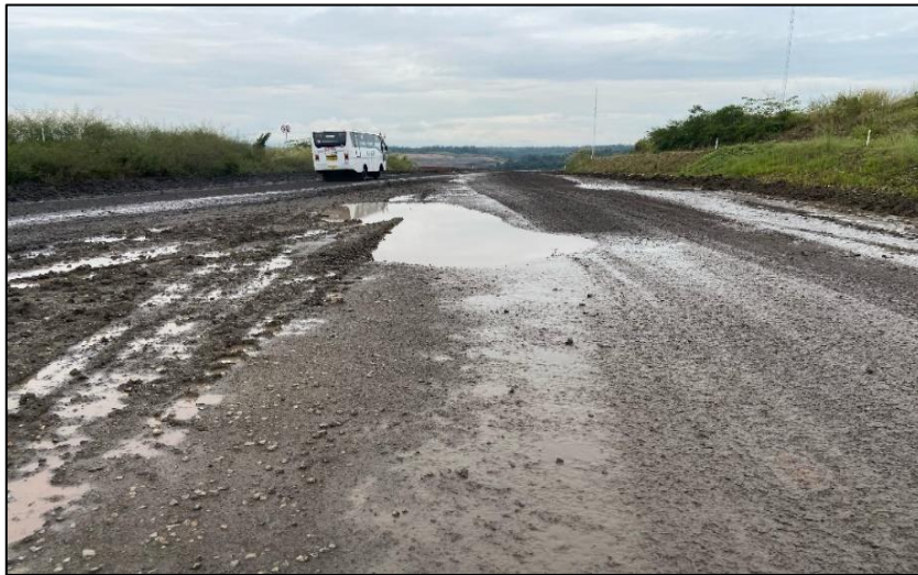
Gambar 4.8 Potholes atau Lubang
