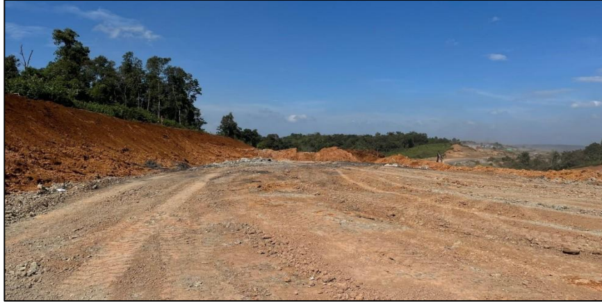
Gambar 4.4 Cross Fall Jalan Kurang Terbentuk
