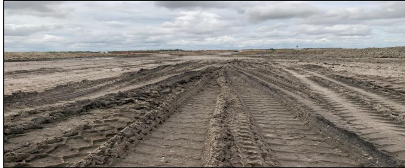
Gambar 4.9 Lendutan membentuk ban roda
