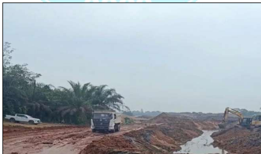
Gambar 4.8 Sistem Drainase pada Jalan Tambang
