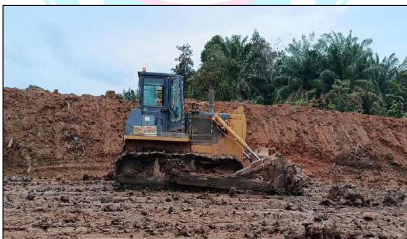
Gambar 4.9 Pelebaran Jalan Angkut oleh Komatsu D85ESS-2
