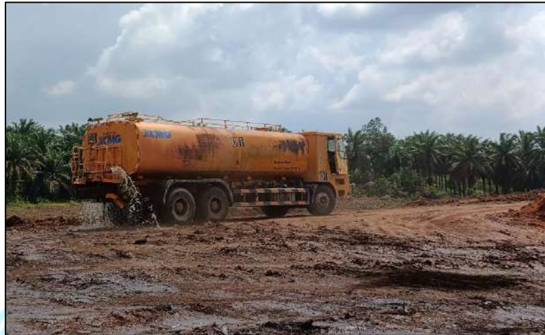
Gambar 4.13 Penyiraman Jalan Angkut oleh WT XCMG G5
