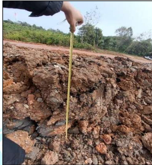
Gambar 4.7 Tanggul Keselamatan pada Segmen F-G
