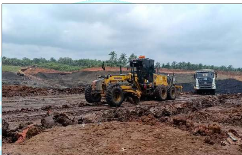
Gambar 4.10 Pelebaran Jalan Angkut pada tikungan
