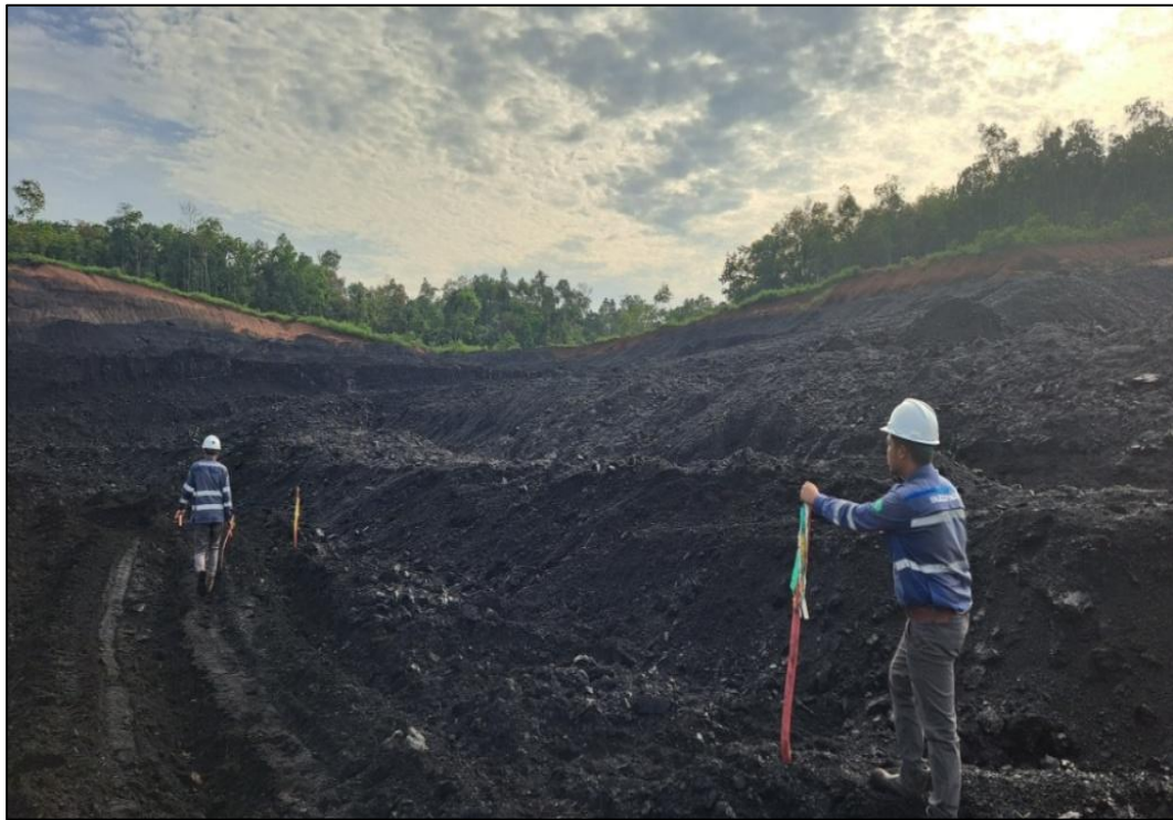
Gambar E.5: Kegiatan Pemasangan Patok di Area Pit
