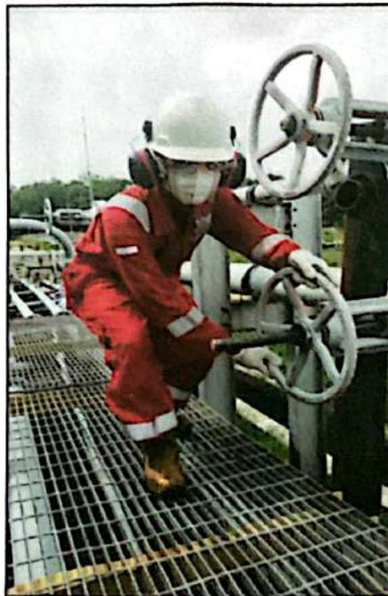
Gambar C.2 Membuka Valve Pompaan
