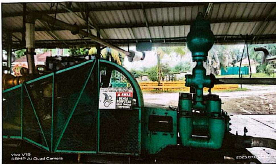
Gambar 4.1 Pompa Ekspor Tipe Piston
