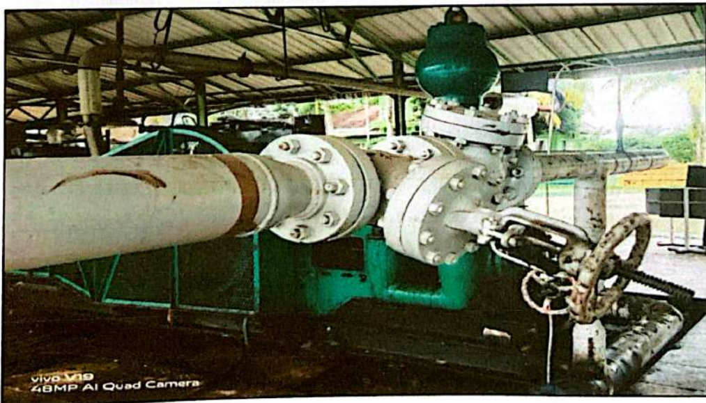
Gambar 4.3 Pipa Saluran Minyak 6 Inch
