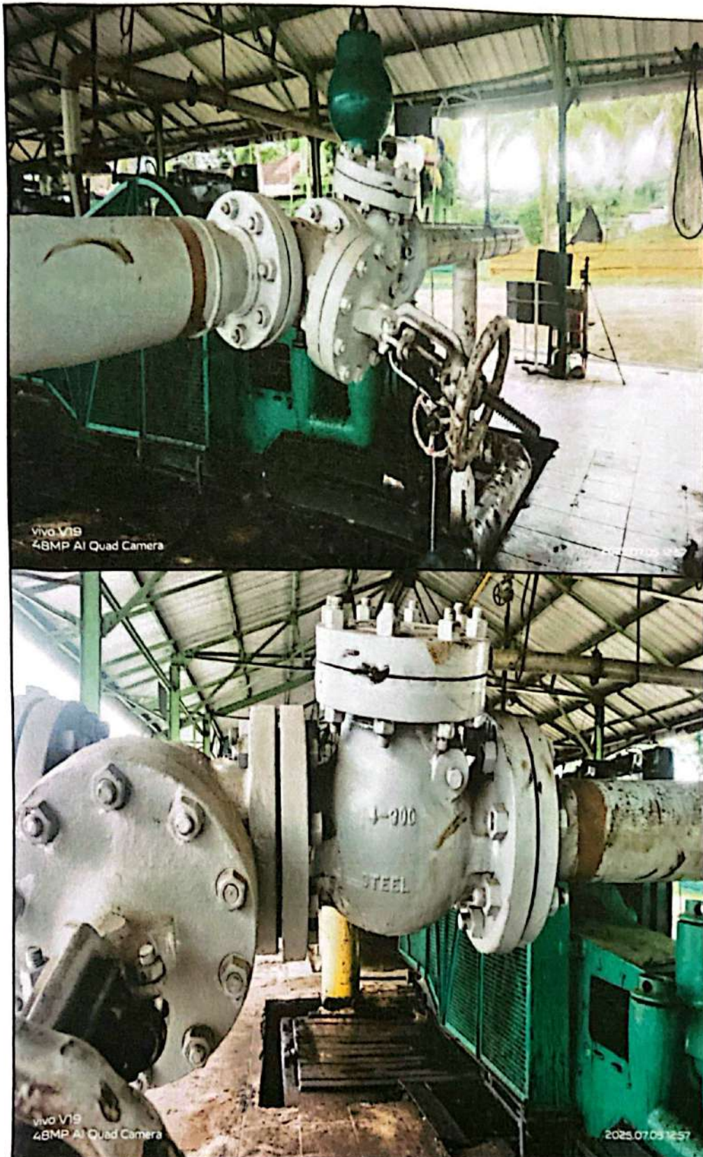
Gambar C.11 Pipa Jalur Pengangkutan Minyak Yang Dikirim Ke Pusat Pengumpul Produksi Prabumulih
