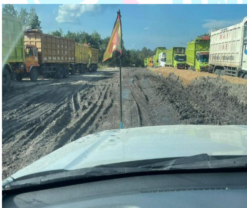
Gambar F.5 Kondisi Jalan Hauling
