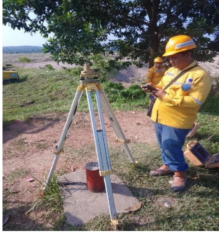
Gambar A.1 Pemasangan Tripod
