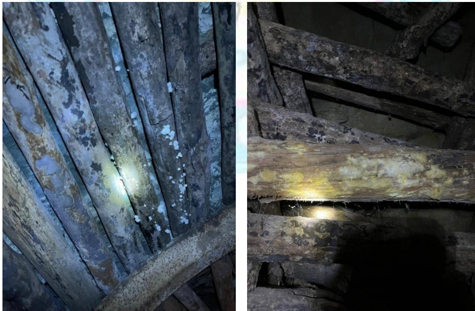
Gambar C.1 Detail rongga kosong ( void ) antara batuan atap dan blok kayu.
