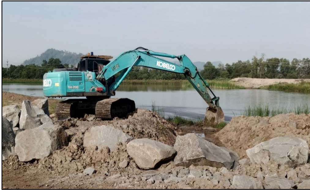
Gambar 4.1. Pembuatan saluran dan Pemasangan Batu KPL AL-04
