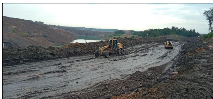
Gambar 4.6 Perataan Jalan Menggunakan Alat Moto Greder 4230D.
