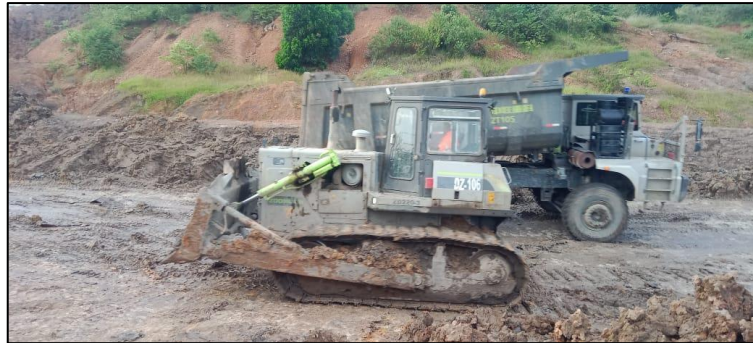
Gambar 4.5 Penyekrapan Jalan Menggunakan Bulldozer Zoomlion 220.
