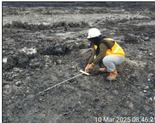
Gambar B. 2 Mengukur Burden & Spasi
