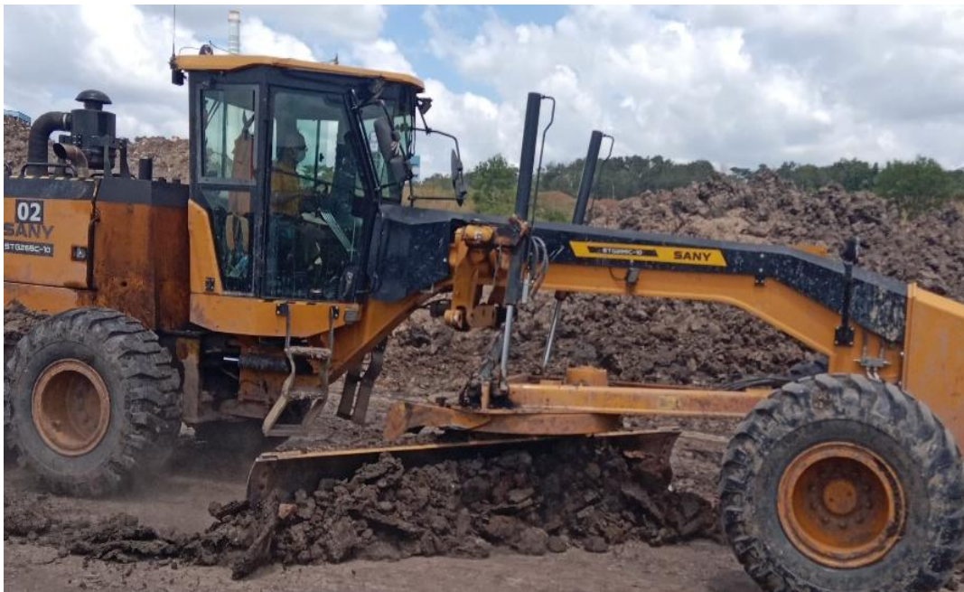
Gambar 4.2 Perataan Jalan Dengan Menggunakan Alat Motor Grader
