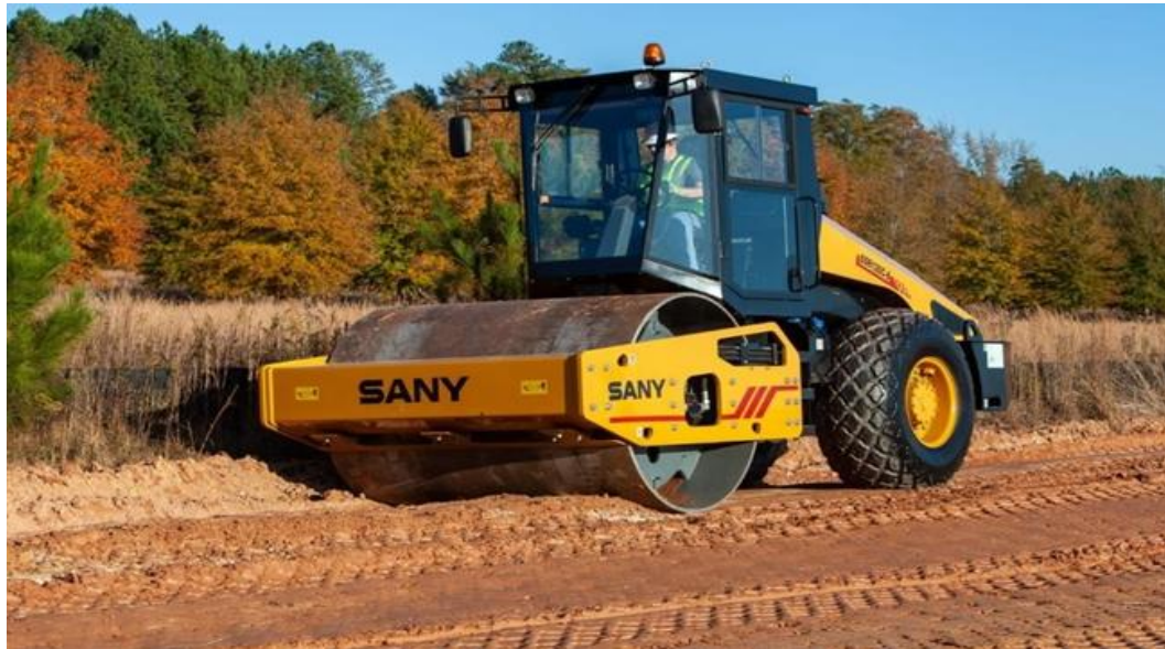
Gambar 4.3 Pemadatan Jalan Dengan Menggunakan Alat Compactor
